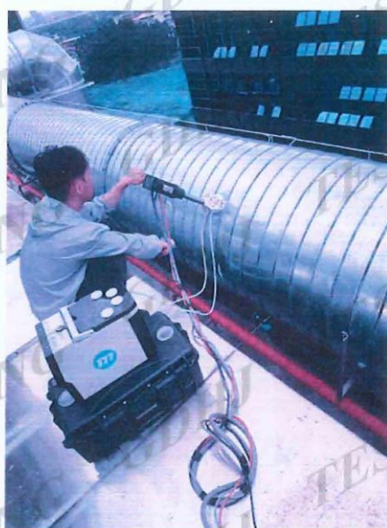
调墨、印刷、干燥工序 DA001 废气排放口处理前
